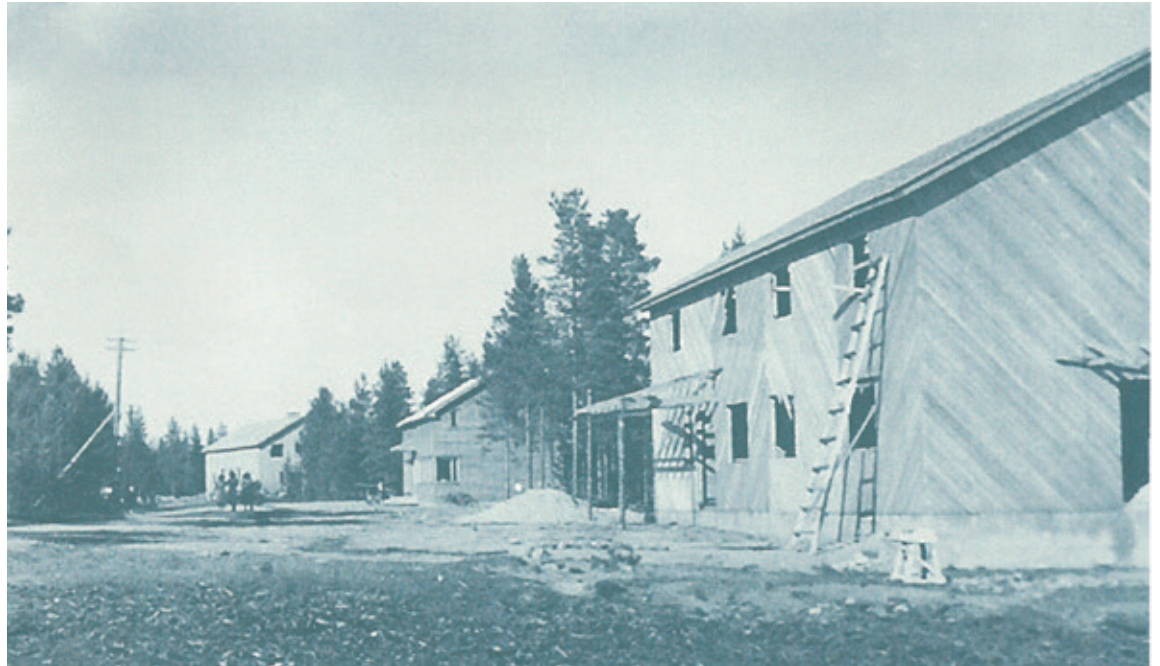
Yli-Lestin työväentalot rakenteilla kesällä 1949. Vasemmalla SDP:n talo ja oikealla SKDL:n talo
